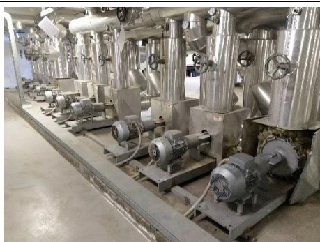
Pompe di circolazione riscaldamento
