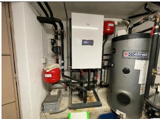
Caldaia e bollitore
