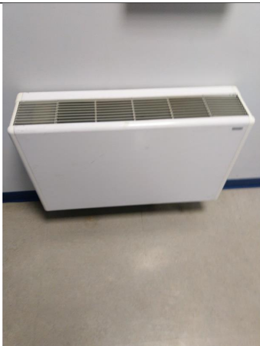
Ventilconvettore
