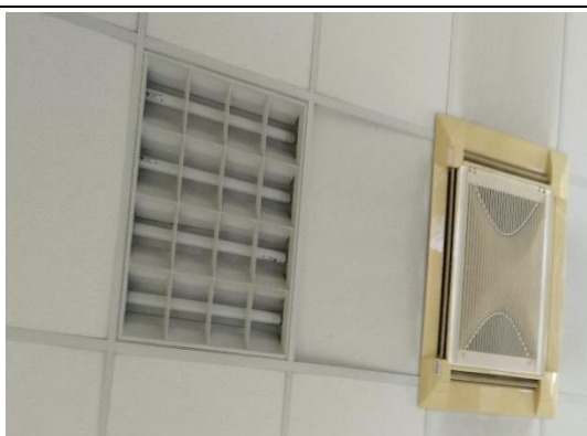
Illuminazione tipo e cassetta tipo a soffitto
