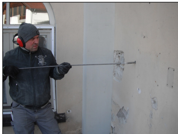
Perforazione per videoispezione e pulizia del foro
