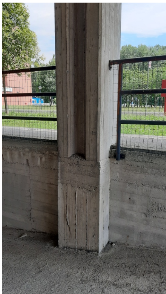
7 - collegamento pilastro 60x60 con pilastro ad H - A
