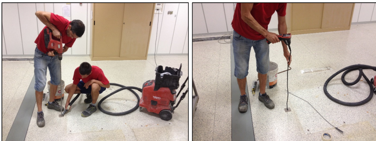
Realizzazione della forometria e successiva indagine videoendoscopica (Zona SO/2/61).
