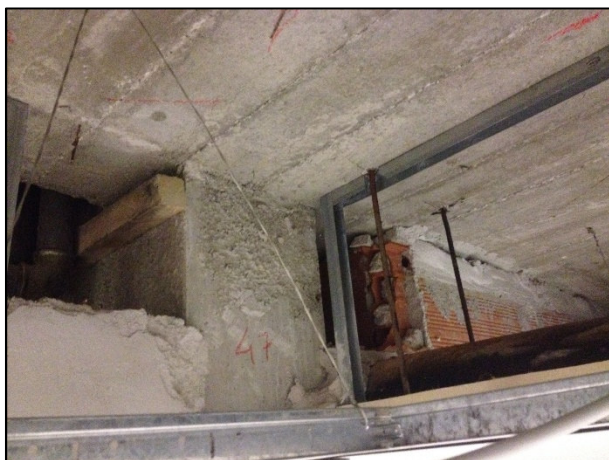
Zona PI/2/08: particolare del pilastro nella sua parte sommitale e una fase dell'indagine pacometrica in seguito alla demolizione del rivestimento in laterizio.
