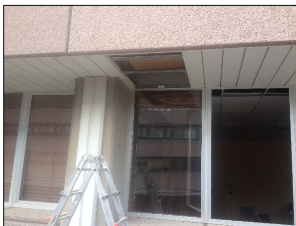
Zona TR/C/50: appoggio verso pilastro PI/3/09. Zona TR/2/45: fase di rimozione controsoffitto.
