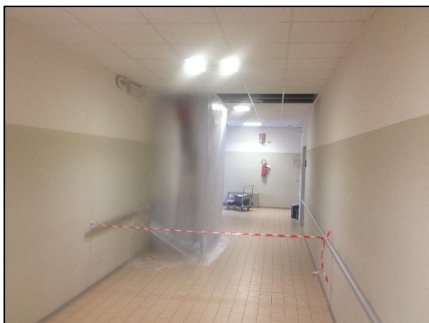
Una fase delle lavorazioni con parziale compartimentazione dell'area di lavoro al primo piano (tenuto conto della necessità di passaggio del personale ospedaliero). Nella foto a dx controsoffitti rimossi e imballati prima del trasporto in discarica.
