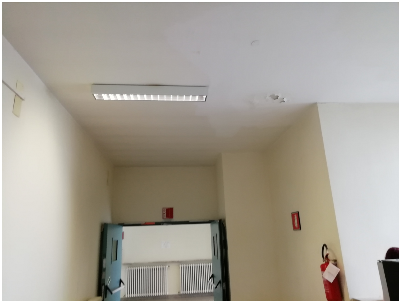
5 - infiltrazione copertura corpo centrale
