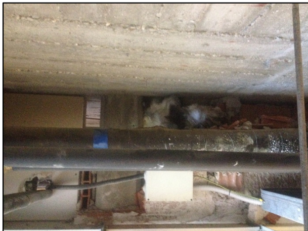
Zona PI/1/04: vista pilastro ad H dal lato corridoio. Sono presenti vari impianti, isolamenti in lana minerale e rivestimento in laterizio. A destra lo stesso pilastro visto dalla stanza (aula), in cui si nota anche una forometria sull'appoggio della trave adiacente.
