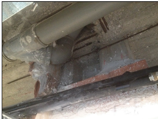
Zona PI/1/04: vista pilastro ad H dal lato corridoio. Sono presenti vari impianti, isolamenti in lana minerale e rivestimento in laterizio. A destra lo stesso pilastro visto dalla stanza (aula), in cui si nota anche una forometria sull'appoggio della trave adiacente.
