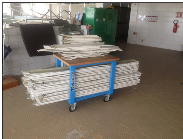
Una fase delle lavorazioni con parziale compartimentazione dell'area di lavoro al primo piano (tenuto conto della necessità di passaggio del personale ospedaliero). Nella foto a dx controsoffitti rimossi e imballati prima del trasporto in discarica.
