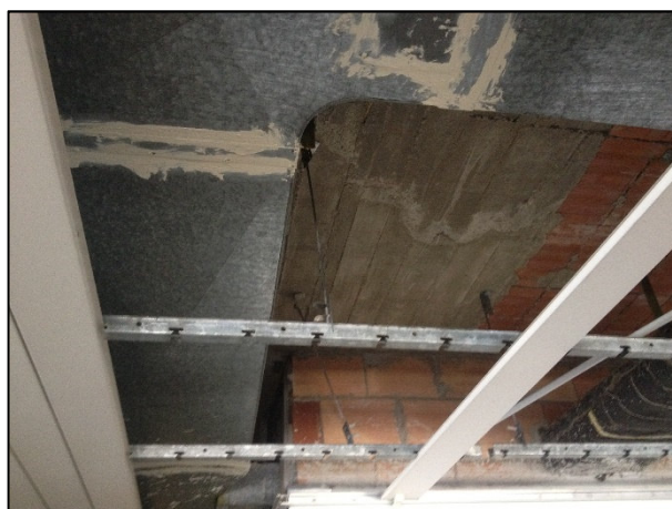
Zona PI/3/10: pilastro e canali aria adiacenti. Zona TR/C/51: trave in spessore verso mezzeria.
