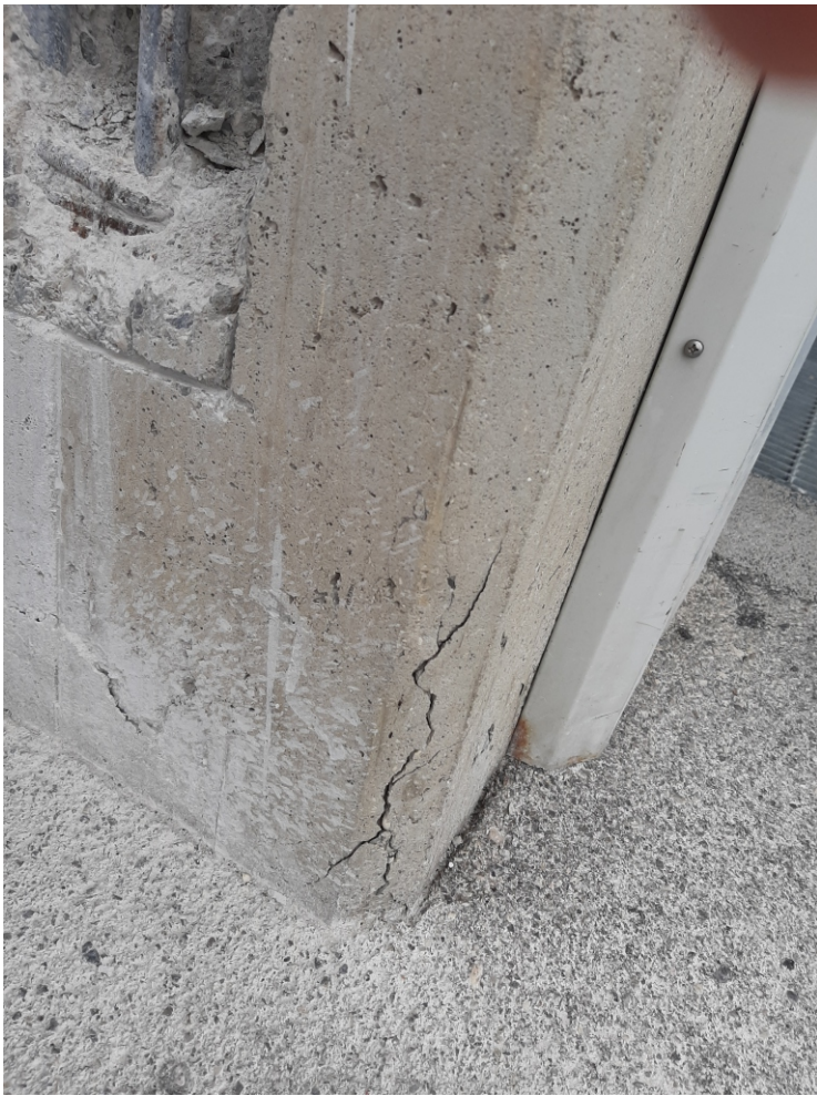
3 - sbrecciature di spigoli
