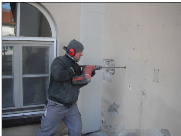
Perforazione per videoispezione e pulizia del foro
