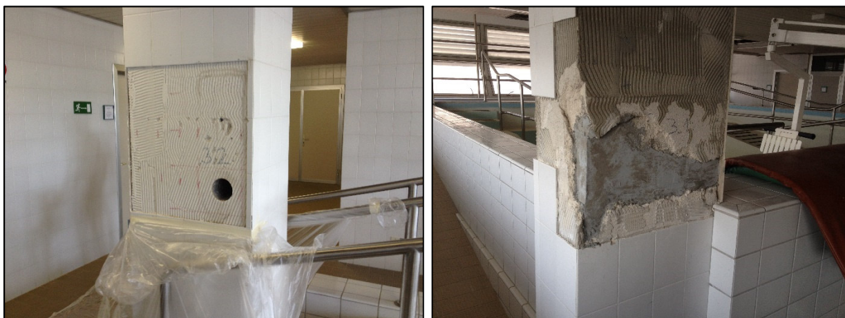
Campione prelevato dal pilastro PI/3/10 e ripristino a seguito del carotaggio sul pilastro PI/3/15.
