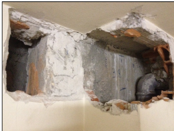
Zona PI/3/11: particolare pilastro visto dal lato corridoio e dal lato stanza (deposito).
