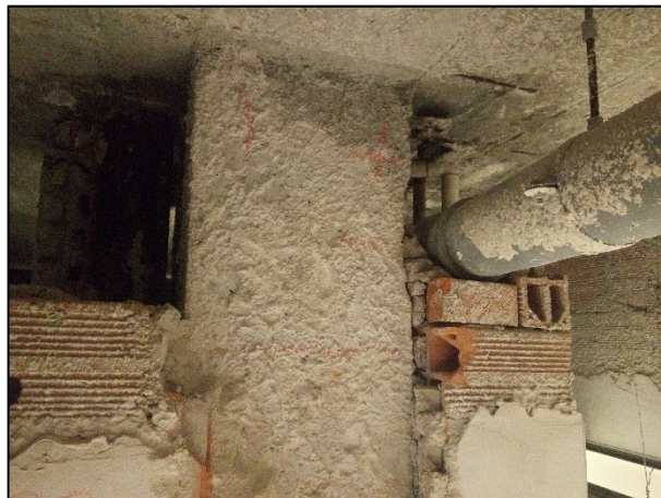
Zona PI/2/05: una fase delle indagini sul pilastro e compartimentazione dell'area di lavoro. Zona PI/2/06: particolare pilastro con rivestimento in laterizio e tubazioni su entrambi i lati.
