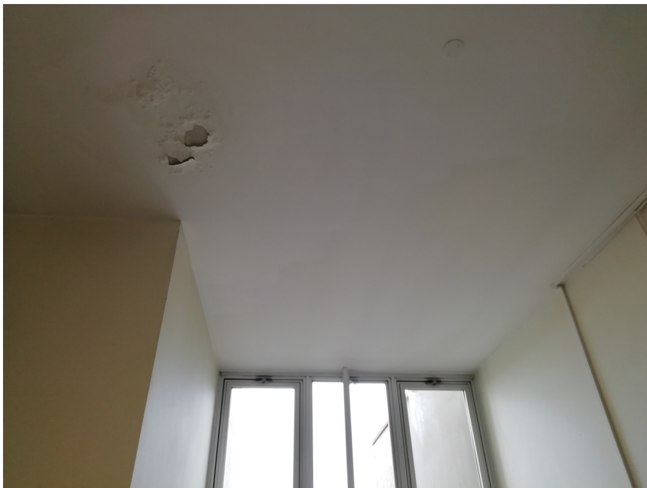
6 - infiltrazione copertura corpo centrale
