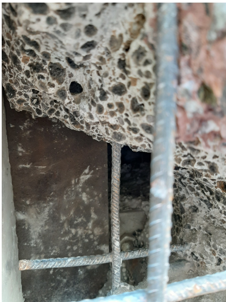
8 - Ancoraggio Pannello Prefabbricato - A
