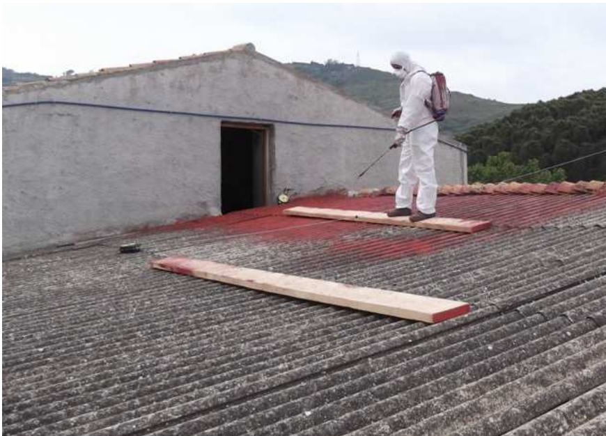
Fase di incapsulamento effettuato ripartendo il peso dell'operatore su un asse di legno
