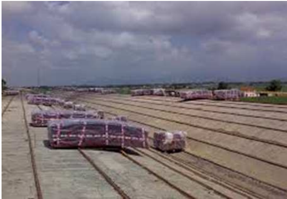
Bancali predisposti in quota, durante la rimozione
