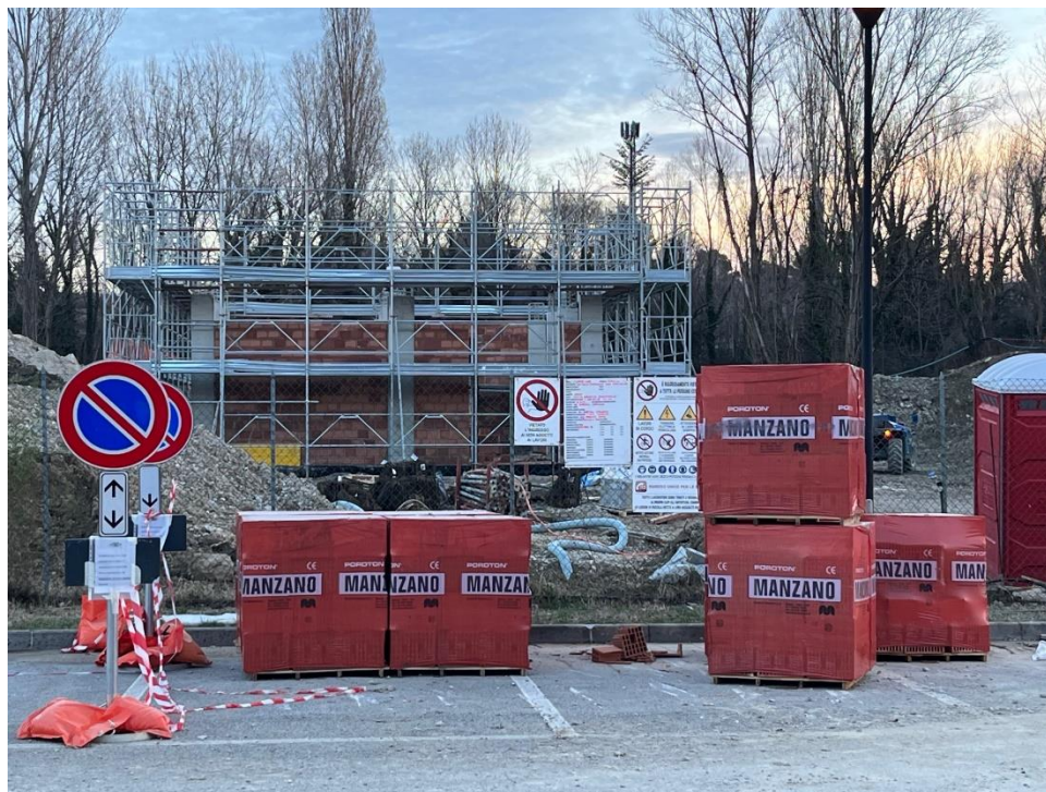
Lavori di realizzazione del nuovo edificio COT
