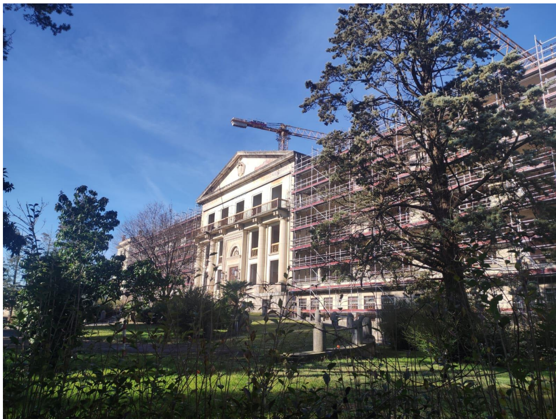
Lavori di cantierizzazione e preliminari edificio ex pneumologico
