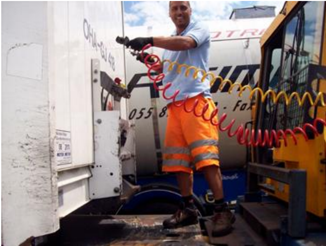
(Distacco delle tubazioni)
