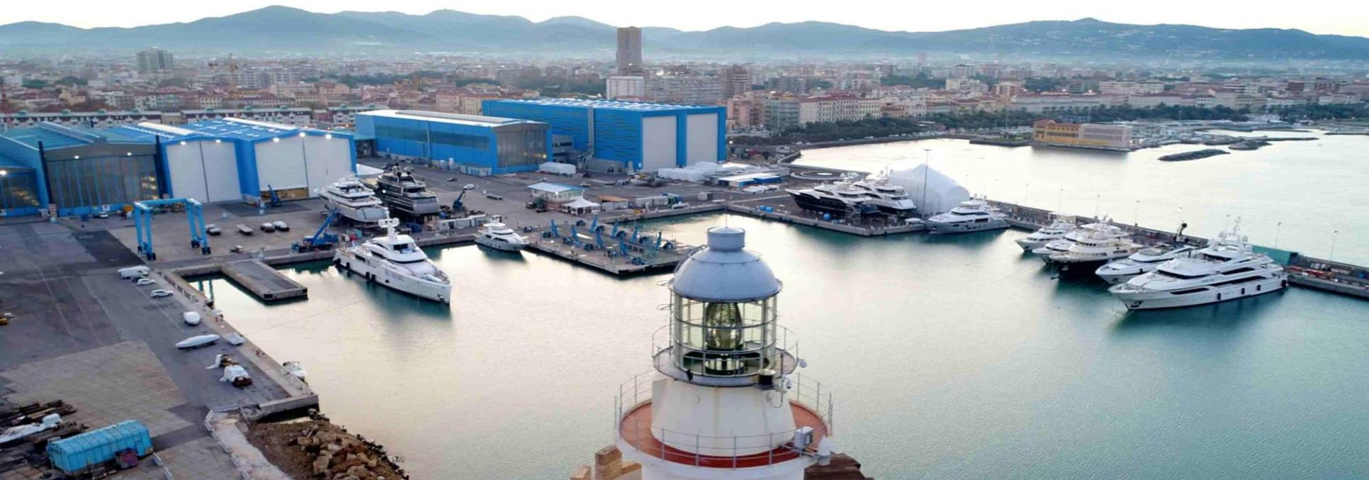
Piazzali attrezzati, banchine di ormeggio ed infrastrutture di alaggio e varo per la manutenzione, il refitting e la trasformazione di yacht di oltre 50 m
