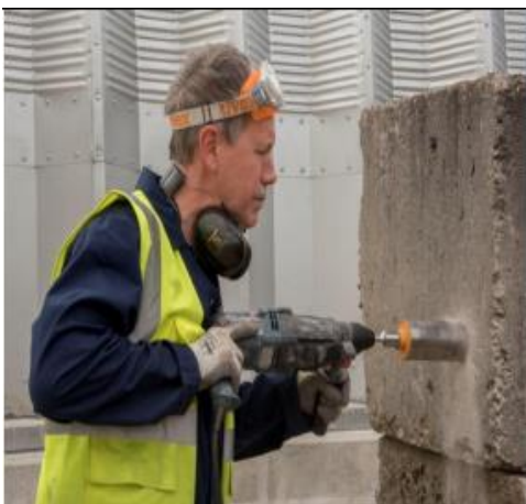
Carotaggio senza aspirazione della polvere
