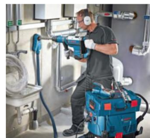
Foratura con adattatore di aspirazione per la bocca del foro
