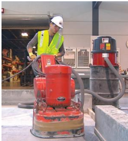
Fresatura con aspirazione della polvere
