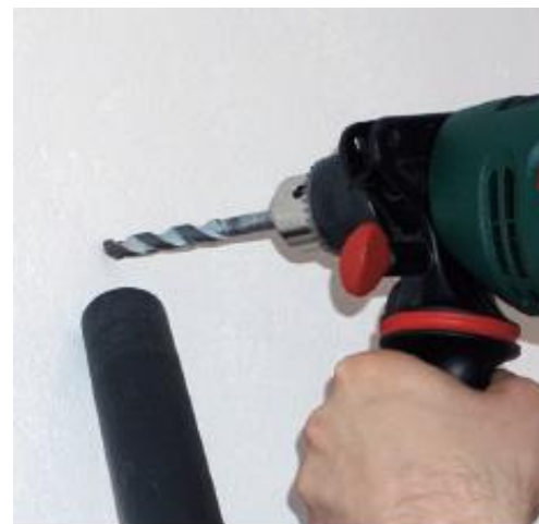
Foratura con bocchettone di aspirapolvere sotto il foro
