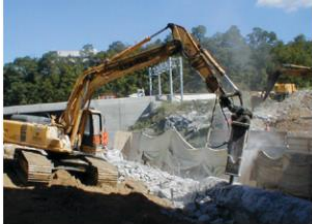
Escavatore dotato di cabina chiusa
