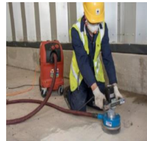
Levigatura con aspirazione della polvere
