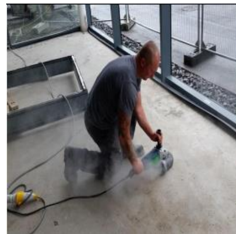
Levigatura senza aspirazione della polvere
