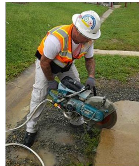
Uso di sega elettrica portatile ad umido
