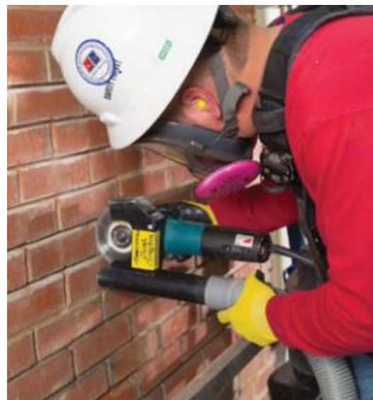
Smerigliatura con aspirazione della polvere
