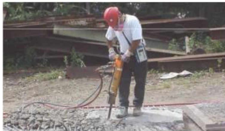
Uso di martello pneumatico a umido
