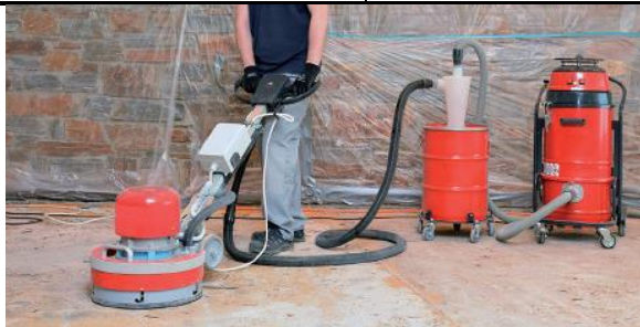
Pre-separatore (al centro) e aspiratore (a destra) quando si utilizza una levigatrice per pavimenti
