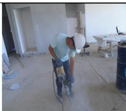
Uso di demolitore senza aspirazione della polvere
