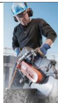
Uso di sega da muratore ad acqua
