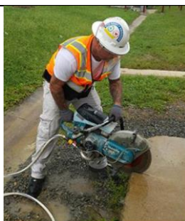
Uso di sega elettrica portatile ad umido
